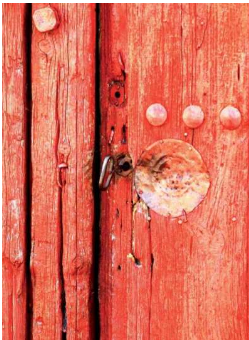
Saldeana. Detalle de una puerta.
