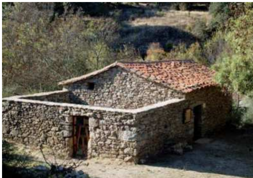
Lumbrales. Rehabilitación del molino del Tío Justo.
