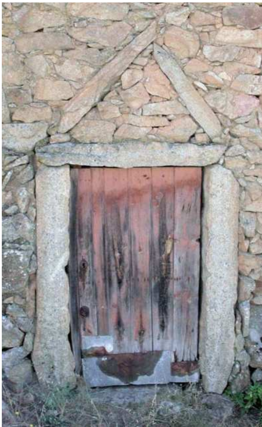
Detalle de la arquitectura tradicional.
