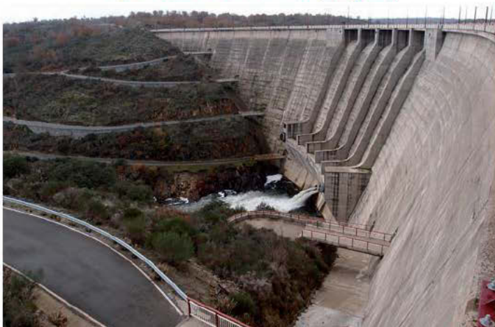
Presa del Embalse de Iruña
