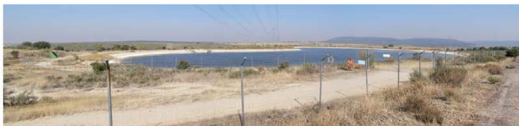
Estanque de regulación de aguas de lluvia y escorrentía de la mina de Saelices
