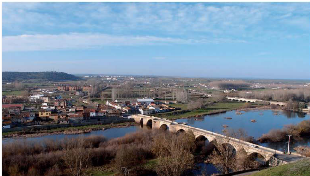
Zona de inundação em Ciudad Rodrigo
