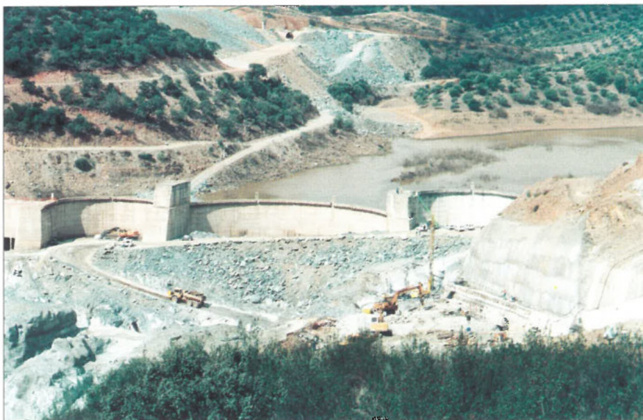
Obras de construcción de la Presa de Alqueva.
