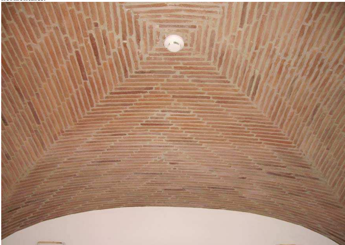
Fig. 4: La bóveda de rosca se caracteriza por la colocación del ladrillo de canto, dejando visto su parte más estrecha.
