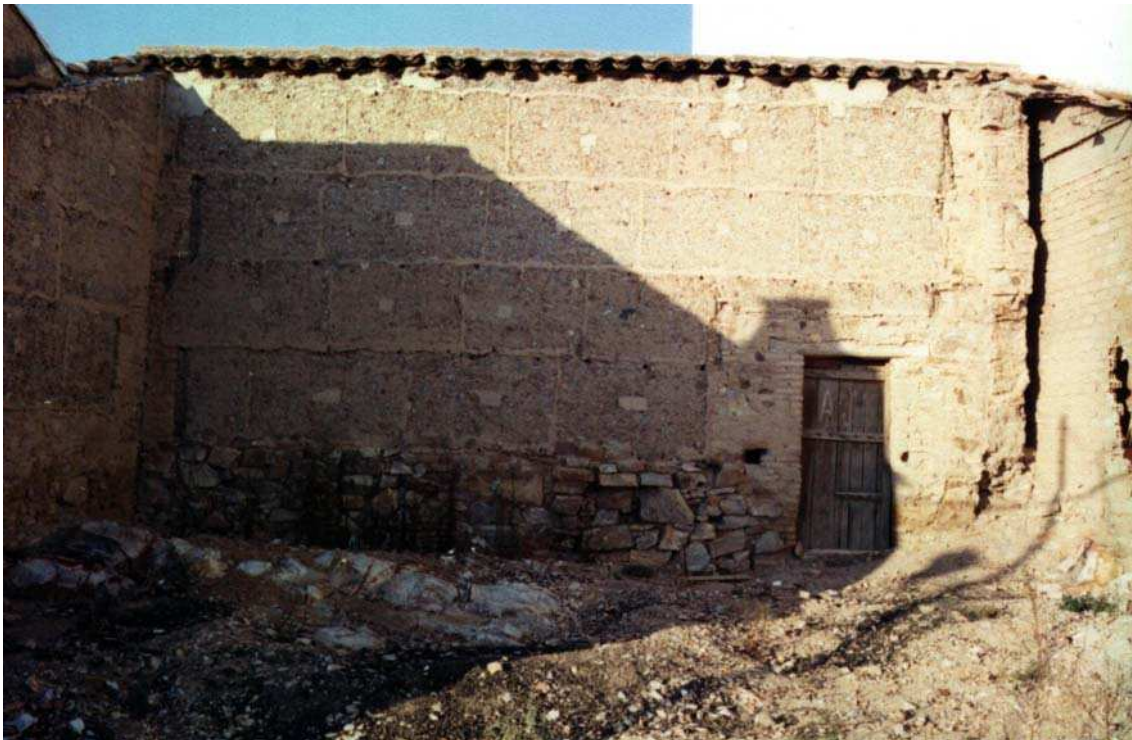
Fig. 2: Las bases constructivas se repiten a ambos lados de la frontera. El adobe y el tapial están presentes en la arquitectura tradicional.
