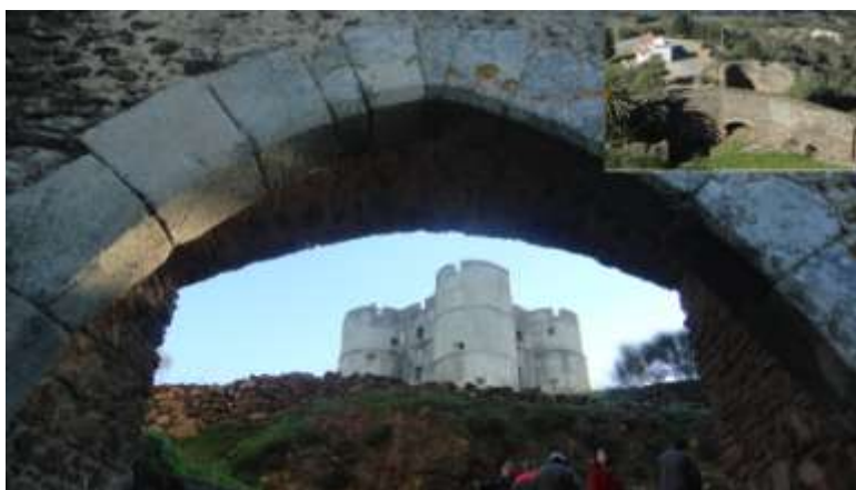
FIG.31. Evoramonte. Castillo artillado desde puerta de entrada de la cerca medieval, y cubo artillero de la cerca.
