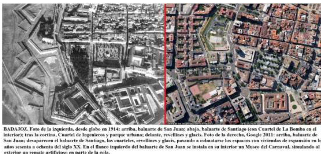
FIG. 15. Badajoz. Baluarte, revellines y cuarteles destruidos.
