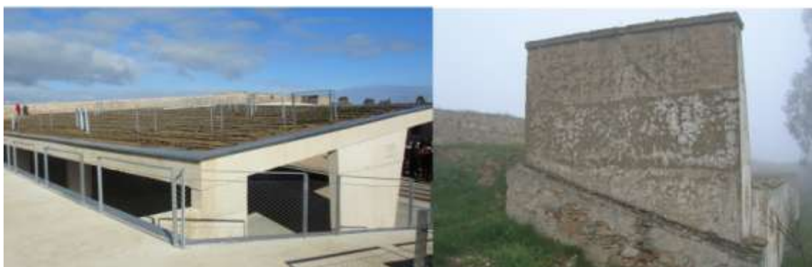
FIG. 34. Terrazas inapropiadas en el Fuerte sustituyendo a tejado con chimenea.
