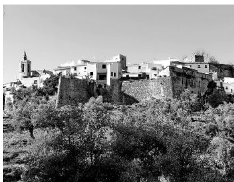
"Baluarte" de la Bica, construido por Rafael de Médicis.
