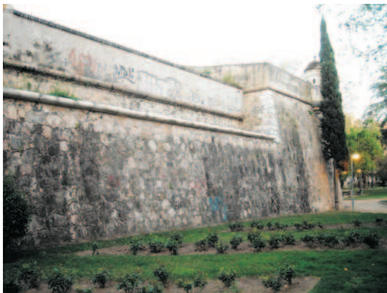
Fig. 2. Baluarte de San Vicente. Podemos apreciar que el recrecido del baluarte está terminado mientras que el nuevo revestimiento de la cara no llegó a concluirse.
