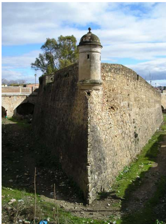
FOTO 20 .- Semibaluarte del Fortín de Cabecera del Puente.
