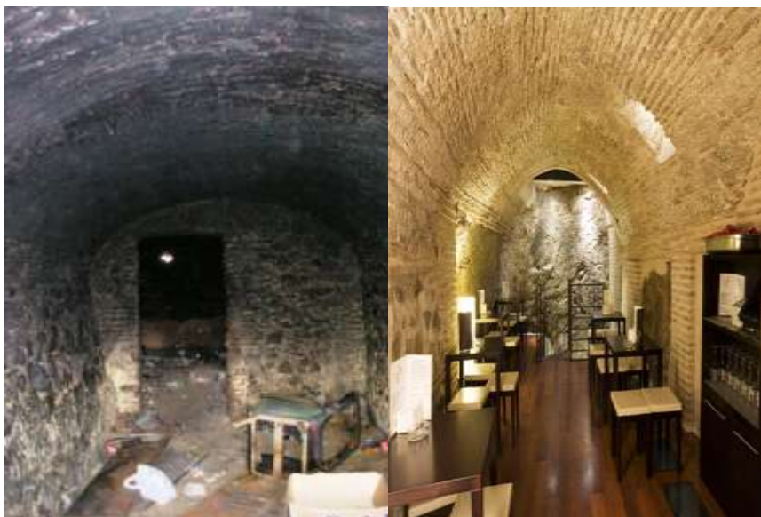
FOTO 24.- Interior del Fuerte de la Picuriña y de un restaurante de Toledo con una configuración estructural similar.
