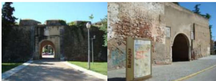
FOTO 1.- Puerta de la Trinidad, exterior e interior
