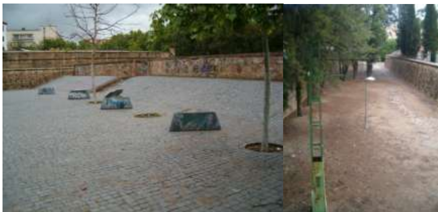
FOTO 15.- Elementos dañados por vandalismo y tramo sin acceso tras el auditorio.
