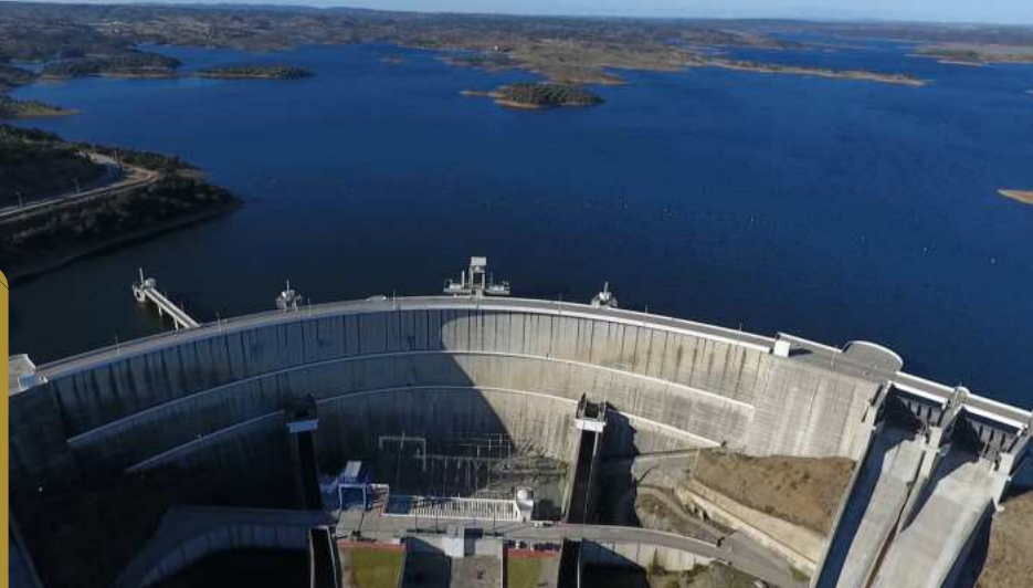
Vista aérea de la presa de Alqueva (Foto: C.M. Portel)
